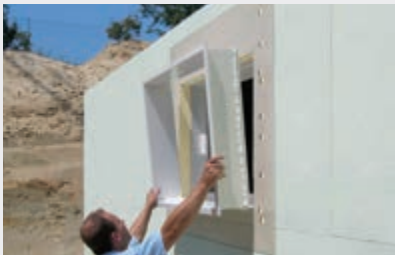
Einfache Montage des Perimeter-Abdeckrahmens
