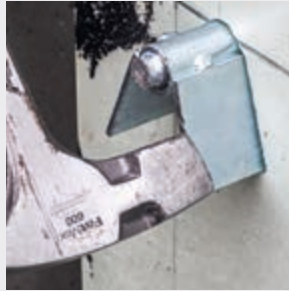
Einschlagen des Befestigungselements
