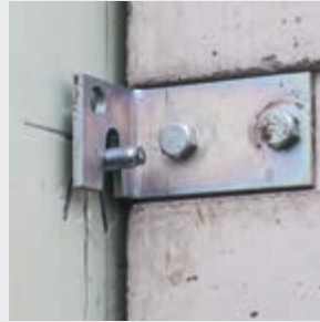
Einhängen des Lichtschachts an die Dübel
