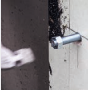
Schwerlastdübel bis zur Hälfte in Betonwand einschlagen
