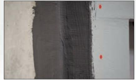
Montagekleber MEABOND auf Perimeter-Abdeckrahmen aufbringen und diesen anschließend gleichmäßig in Öffnung einschieben. MEAFIX PRO umlaufend mit 2-lagiger mineralischer Dickbeschichtung und eingebettetem Glasfaserengewebe abdichten.
