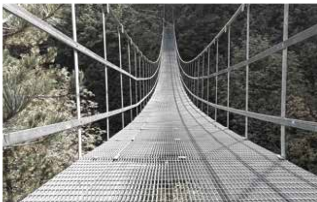
Počasí odolné nerezové rošty s protiskluzovou úpravou a vysokými bezpečnostními nároky.
