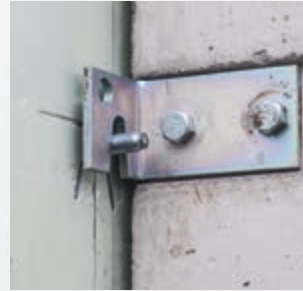
Einhängen des Lichtschachts an die Dübel
