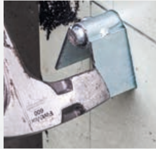
Einschlagen des Befestigungselements
