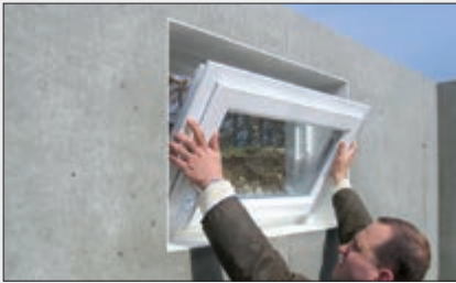
Schneller ist ein Fenster nicht einzubauen: Ein speziell entwickelter Clip am Dreh-Kipp Einsatz ermöglicht ein einfaches Einsetzen und Einklicken in die Zarge – ohne Werkzeug oder Montage von Beschlagsteilen. Einsetzen – Einklicken – Fertig.
