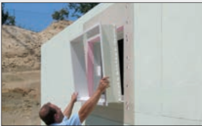
Einfache Montage des Perimeter-Abdeckrahmens
