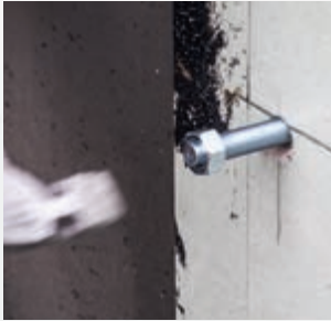
Schwerlastdübel bis zur Hälfte in Betonwand einschlagen
