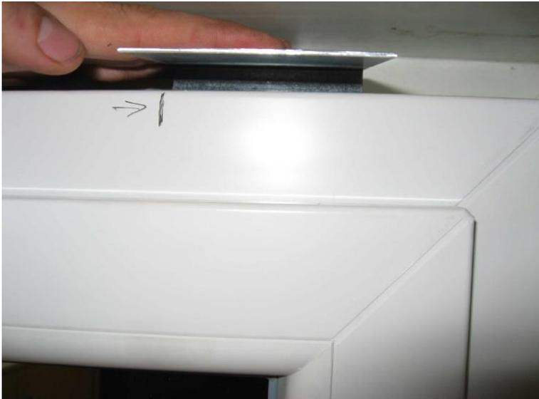
4.) Den Winkel gleichmäßig nach unten drücken und gleichzeitig den Blendrahmen etwas aus der Zarge herausziehen.
