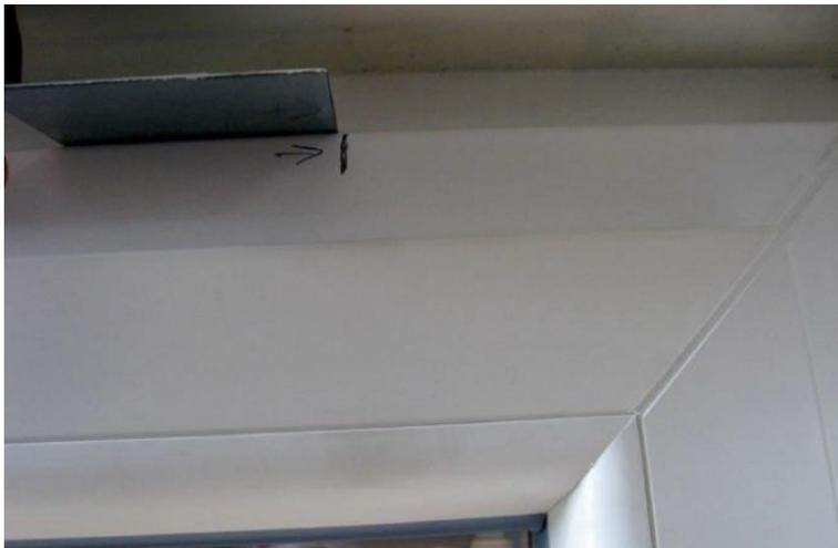
3.) Den Montagewinkel genau im Anschluss an die gemerkte Stelle, von oben in den Spalt einsetzen.
