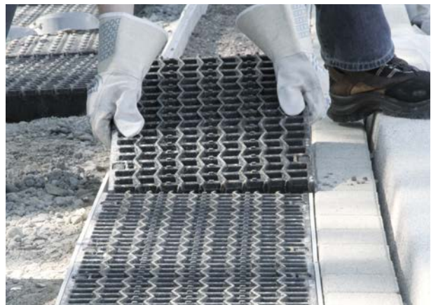
Schritt 4: Abdeckung der Rinnenstränge mit MEA Rosten
