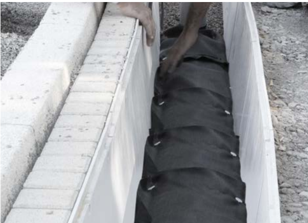
Schritt 1: Einbringen der mit Geotextil bedeckten Abstandhalter in die verlegten Rinnenstränge
