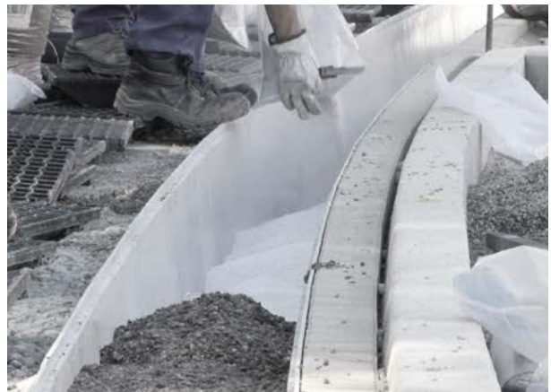
Schritt 2: Einfüllen und Abziehen der ersten Substratschicht „Biocalith K“
