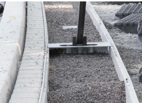
Schritt 3: Einfüllen und Abziehen der zweiten Substratschicht „Biocalith MR-F1“ mit dem Einsatz der MEA Abziehlehre.
