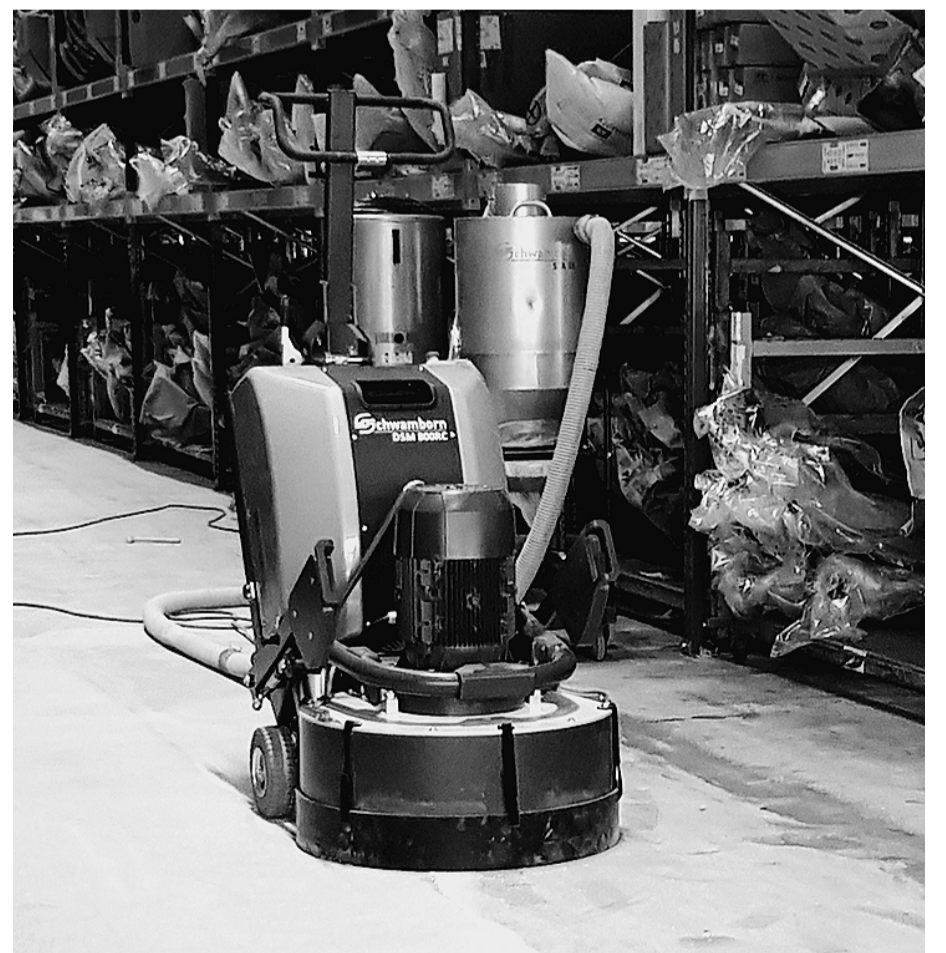
Mithilfe einer sehr guten Schleifmaschinenleistung, passenden Werkzeugen und einer leistungsstarken Staubabsaugung gelang es den Ausführenden in einer Industriehalle vor Kurzem, Epoxidharz- und Polyurethanbeschichtungen sowie Spachtelmassen in nur drei Tagen schnell und gründlich zu entfernen. FOTO: SCHWABORN
