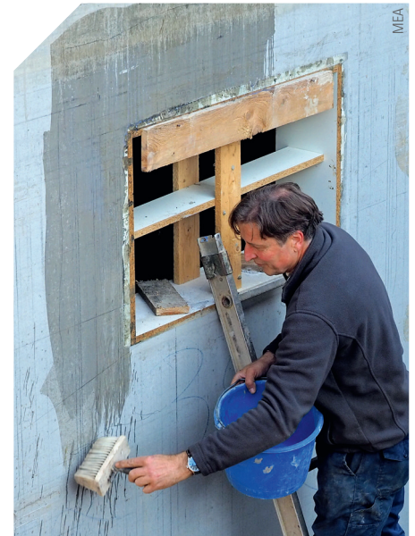
Baustelle auf der Schwäbischen Alb – Auftragen der Grundierung auf die Kellerwand.
