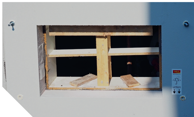
Montagedämmplatte »Meafix Pro« – fixiert an der Hauswand.
