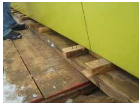
Foto 2: Spodní bednění, které reguluje polohu montovaných římsových desek.
