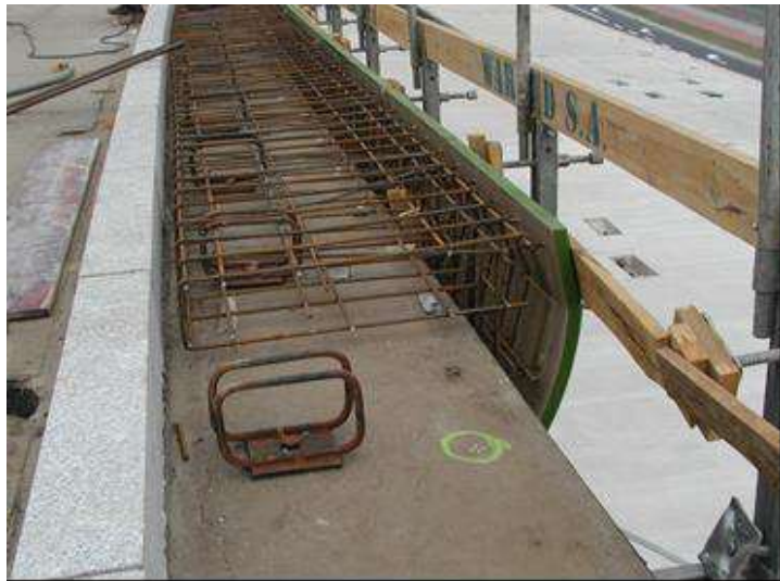
Foto 3: Stabilizace montovaných římsových desek s výztuží monolitické části mostní římsy svařováním.
