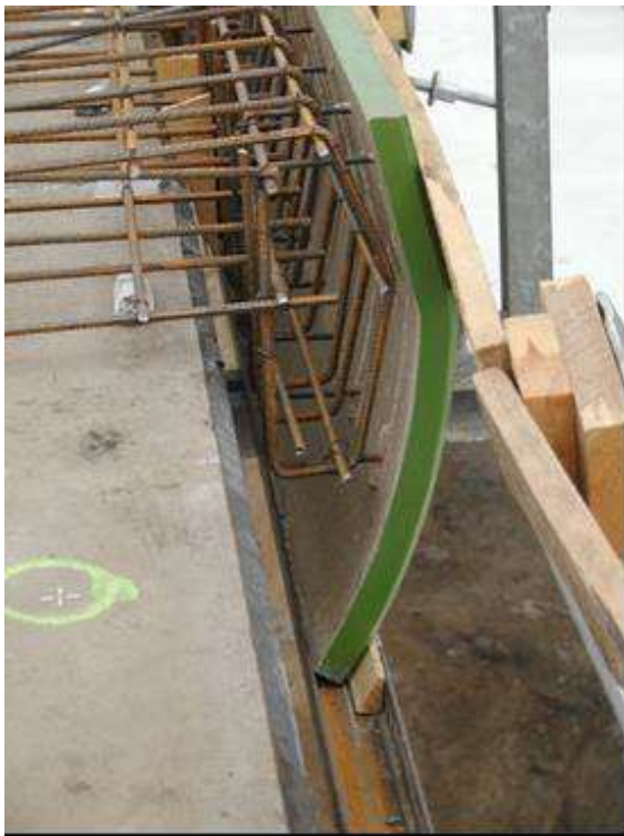
Foto 2: Spodní bednění, které reguluje polohu montovaných římsových desek.
