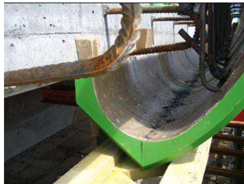
Foto 1: Příklad pracovní plošiny připravené pro montáž římsových desek
