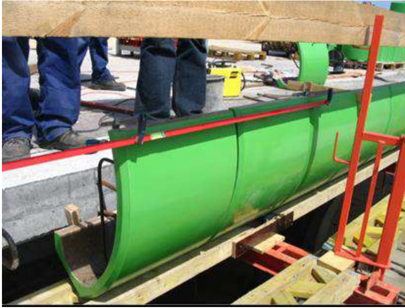
Foto 5: Zajištění správné polohy římsových prefabrikátů.
