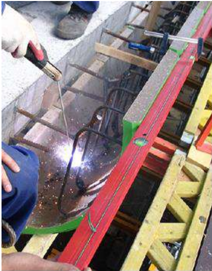
Foto 3: Stabilizace montovaných římsových desek s výztuží monolitické části mostní římsy svařováním.
