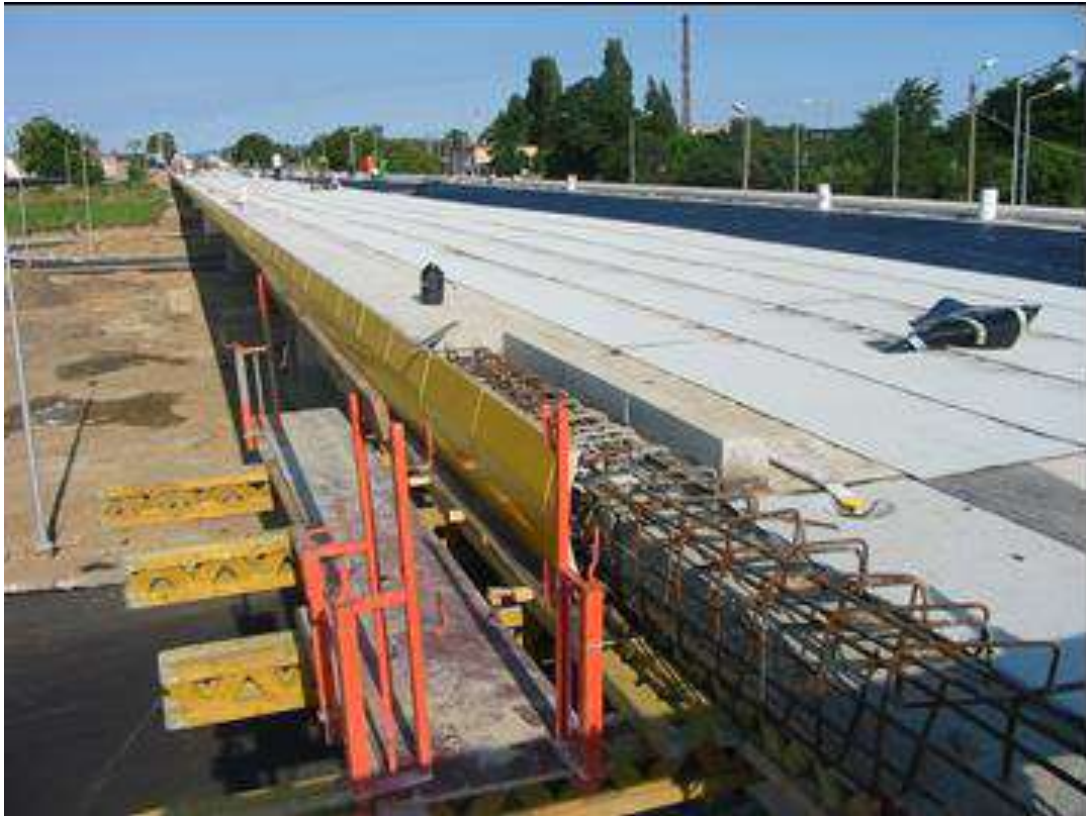
Foto 1: Příklad pracovní plošiny připravené pro montáž římsových desek
