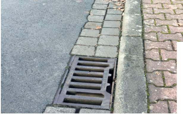
WIDOK PRZED WBUDOWANIEM
