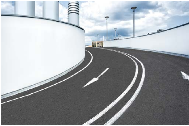
PARKINGS À ÉTAGES
