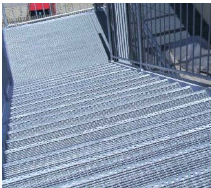
Treppenstufen und Podeste von MEA Metal Applications GmbH mit einheitlichem Maschenbild in MW 30/10.
