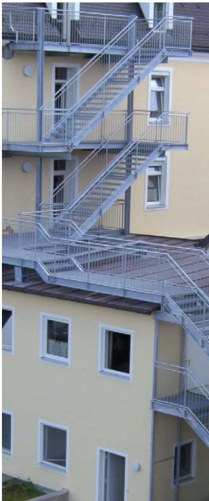
Treppenstufen und Podeste von MEA Metal Applications GmbH mit einheitlichem Maschenbild in MW 30/10.
