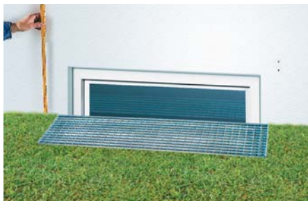
Bohrlöcher vermessen und anzeichnen
