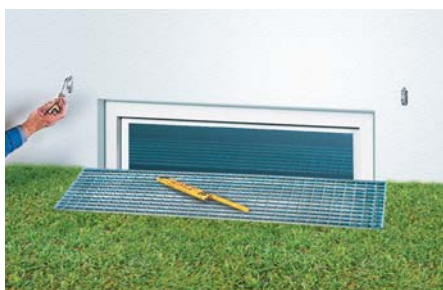
... Beschläge anschrauben
