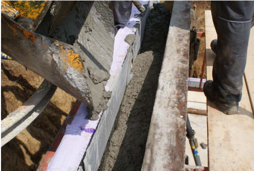
Herkömmliches Betonieren der Kellerseitenwände
