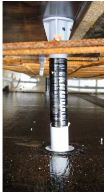
Anbringung der Bewahrung und THEPRO Abstandshalter zwischen der ueren und inneren Schalung
