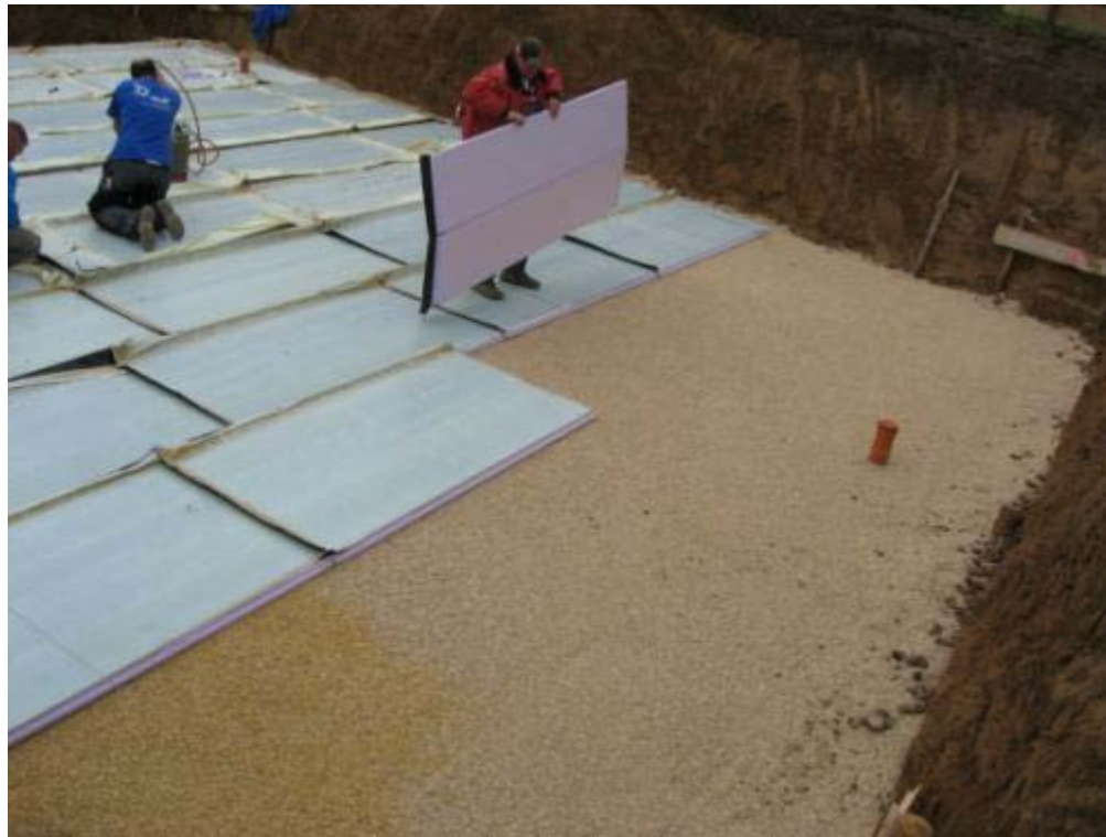
Verlegen der THEPRO Platten auf die Sauberkeitsschicht
