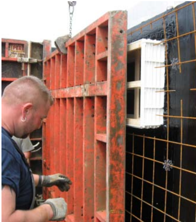
Anbringung der Bewahrung und THEPRO Abstandshalter zwischen der ueren und inneren Schalung
