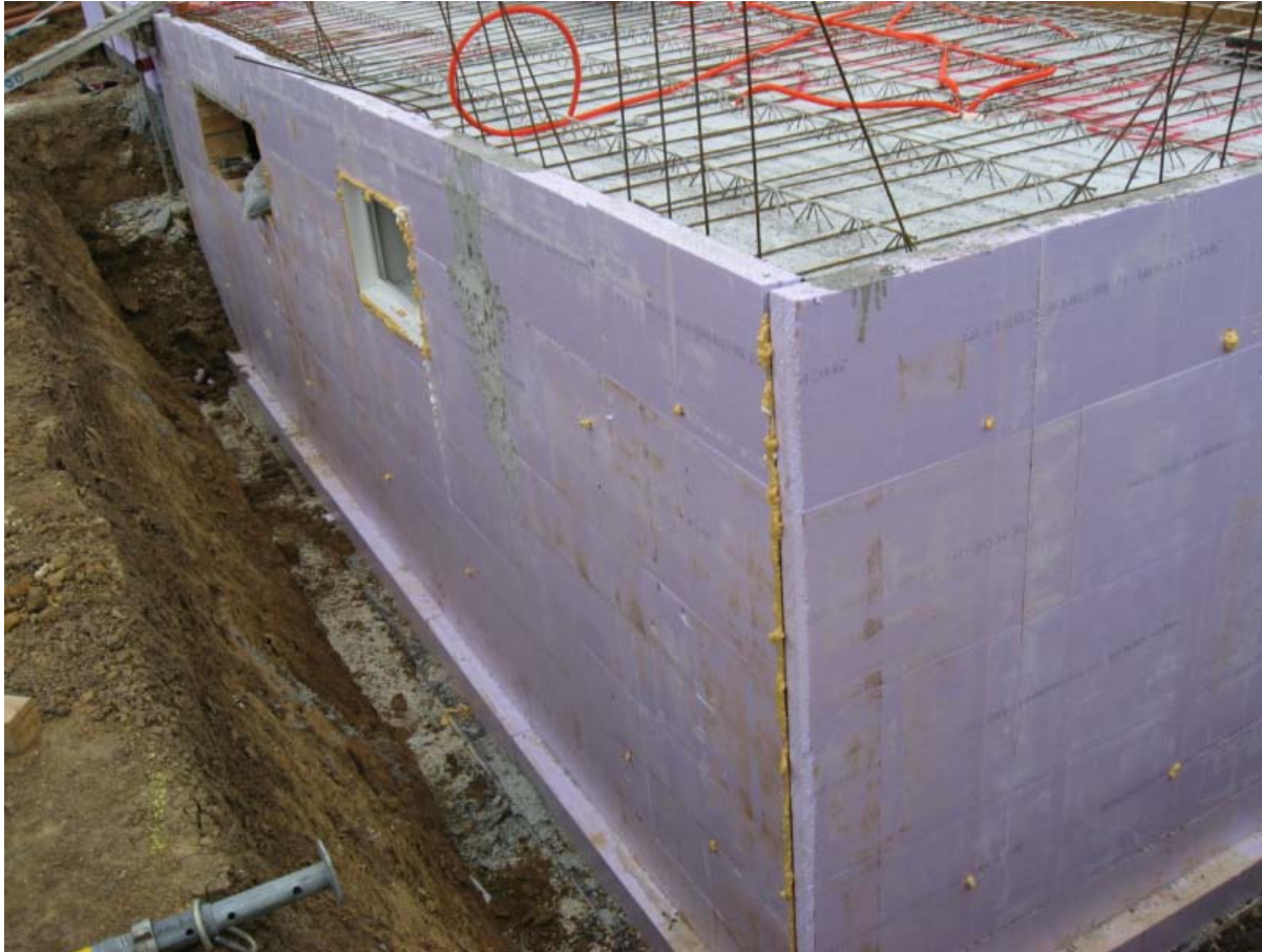
Der 1. gedämmte und abgedichtete THEPRO Rohbaukeller
