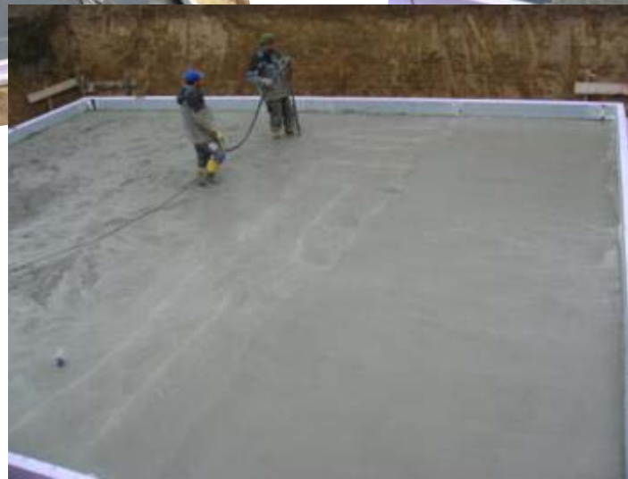
THEPRO Bodengrund-Elemente verarbeitet - Betonieren der Bodenplatte
