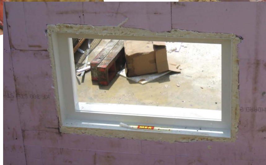
Nach dem Ausschalen werden die Fugen von ausgeschäumt
