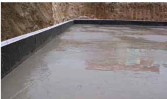
Fertig betonierte THEPRO Bodenplatte.
