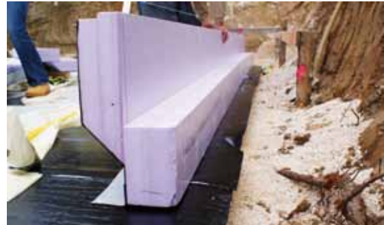
Verlegung der THEPRO Stirrandschalung (SRS) an den Längsseiten.
