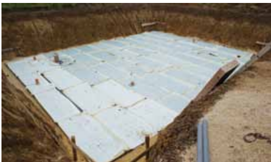
Verlegte THEPRO Bodenplatten.
