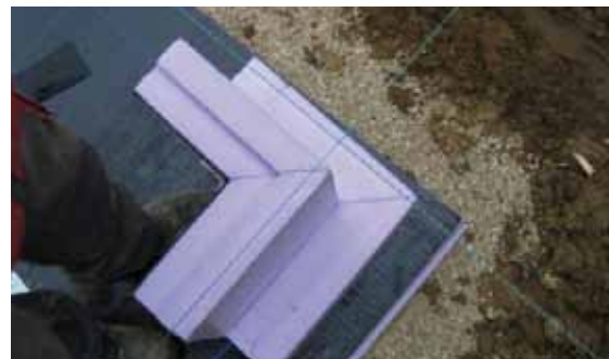
Setzen der THEPRO SRS-Eck-Elemente.
