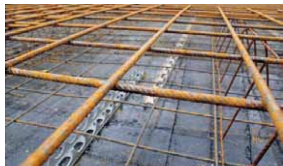
Bewehren der THEPRO Bodenplatte.
