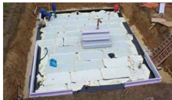
Anbringen der THEPRO SRS-Elemente auf der THEPRO Bodenplatte.
