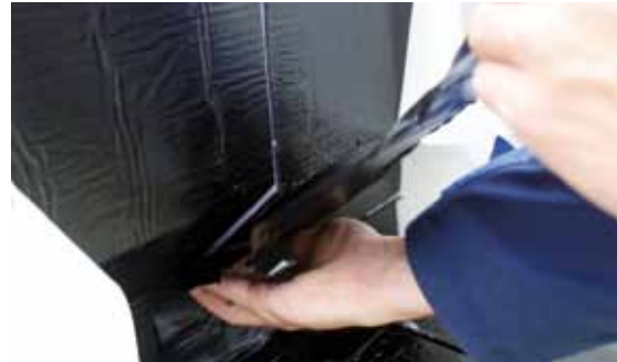
Mit THEPRO Dichtband Stöße abdichten.
