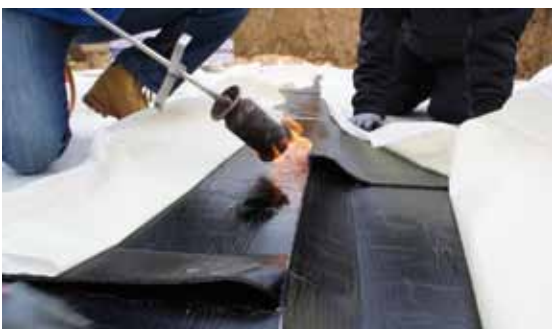
Dichte Verklebung an den Überlappungen mittels Hitze.
