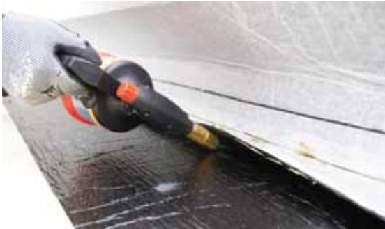
Hinterlaufsicheres Verschweißen mit der THEPRO Bodenplatte.
