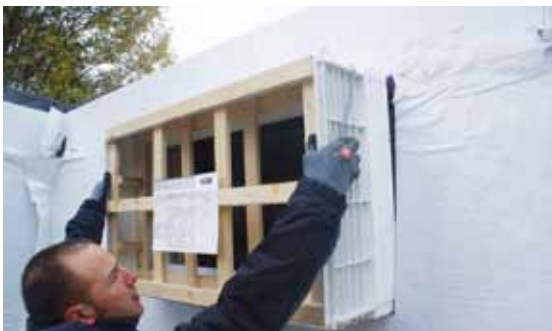
Einsetzen des MEALUXIT Zargenfensters.
