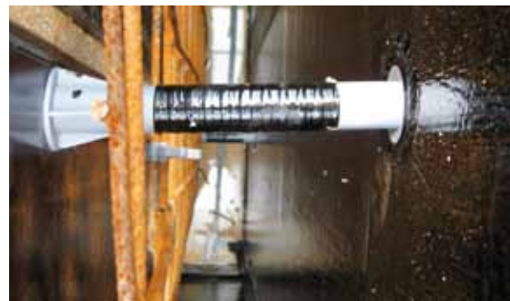
Anbringen der THEPRO Spannstellen zwischen äußerer und innerer Schalung.
