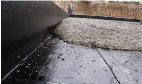
Vergießen des Betons auf der haftenden THEPRO Bodenplatte.
