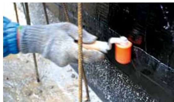
Verkleben des Dichtungsbands.
