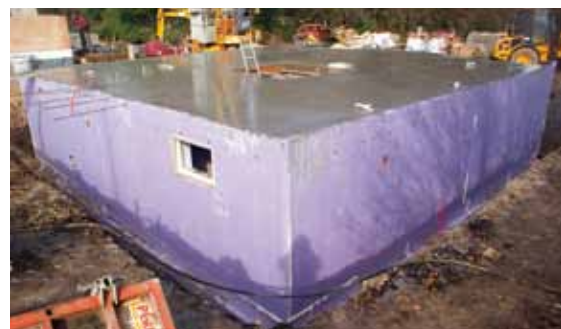
Fertiger Keller mit dem THEPRO Bausystem.
