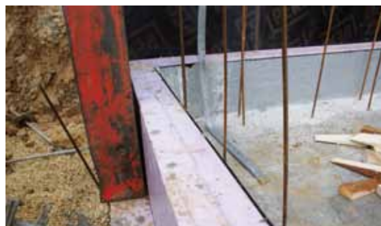
Detailaufnahme der Außenschalung auf dem THEPRO SRS-Element.
