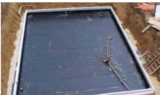
Fertig verarbeitete THEPRO SRS-Elemente.
