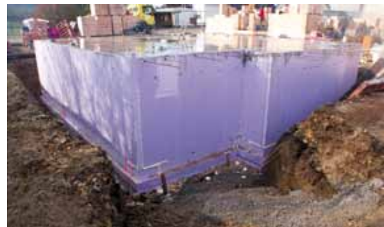
Vollflächige Wärmedämmung und Abdichtung ist gut erkennbar.
