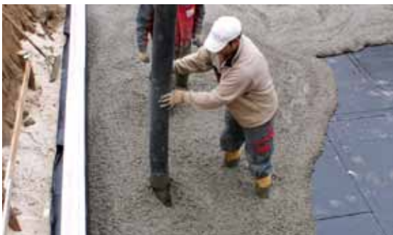
Verdichten und Verteilen.
