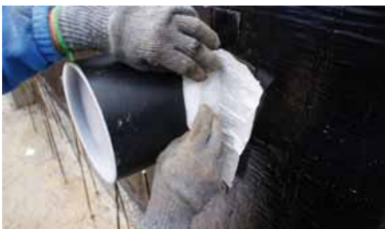
Abdichtung aller Aussparungen mit dem THEPRO Dichtband nach dem Ausschäumen.
