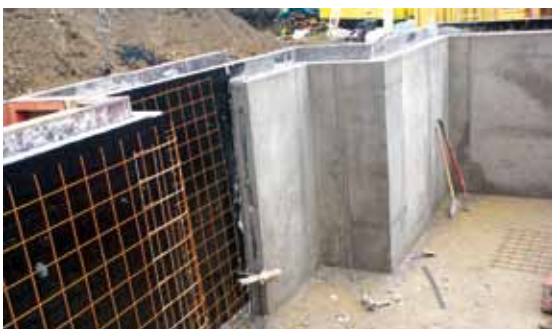
Rechts die fertig betonierte Wände, links das THEPRO Element vor dem Ausbetonieren.
