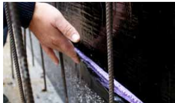
Einsatz des Dichtungsbands.
