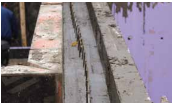
Fertig betonierte Wand mit THEPRO Wandpaneel.
