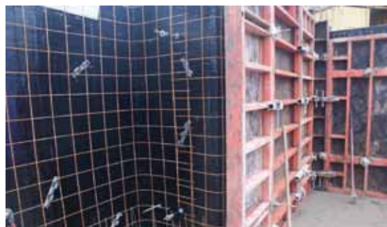
Aufstellen der Innenschalung auf dem Beton der Bodenplatte.
