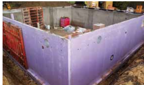
Entfernen der Schalung.
