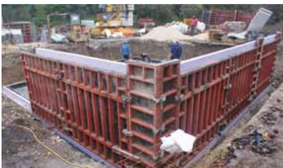
Einbringen des THEPRO Wandelements an die äußere Schalung.
