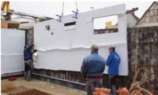
Versetzen des kompletten THEPRO Wandelements.
