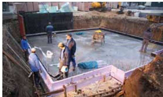
Stellen der Außenschalung auf die THEPRO SRS-Elemente.
