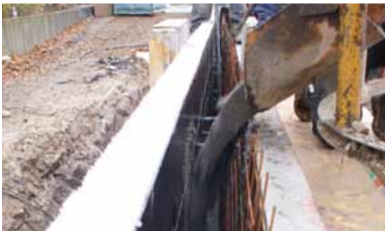
Betonieren der Wände.
