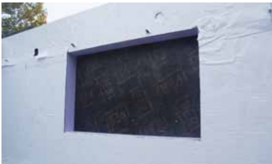
THEPRO Wandelement mit vorgefertigter Aussparung.
