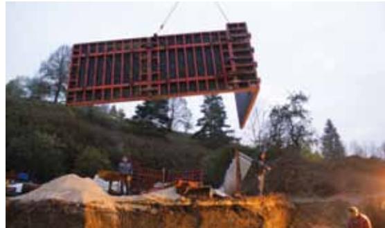
Einschwenken der Außenschalung.
