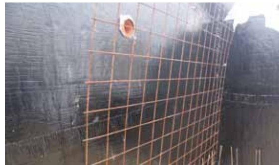
Anbringen der Bewehrung.
