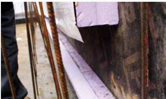
Einsetzen des THEPRO Wandelements.
